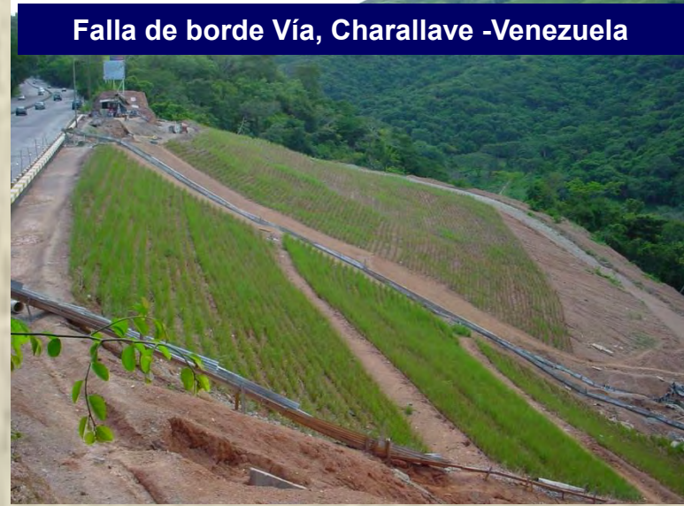
Falla de borde ARC Venezuela
