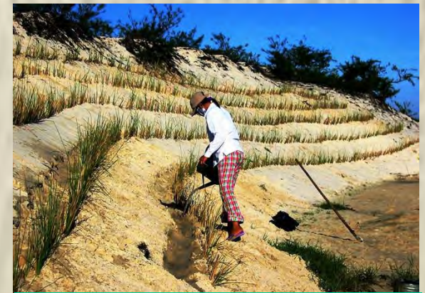
Estabilización de dunas
